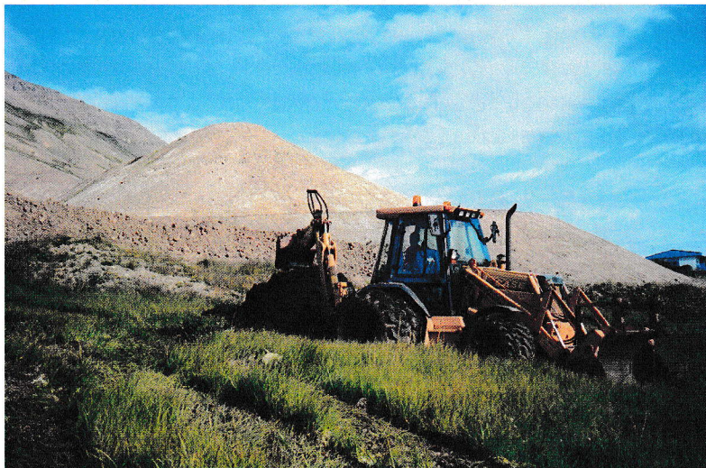
Mynd 14. Könnunarhola staðsett rétt neðan við neðri enda snjóflóðaleiðigarðsins á Siglufirði (Ljósm. Þorsteinn Sæmundsson 1999).
