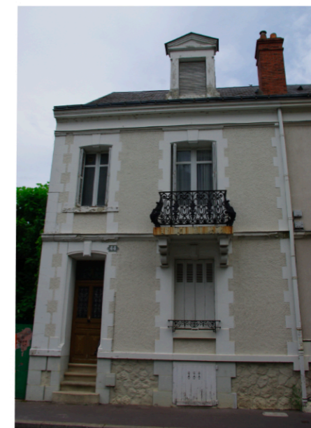
Photo de la façade actuelle
