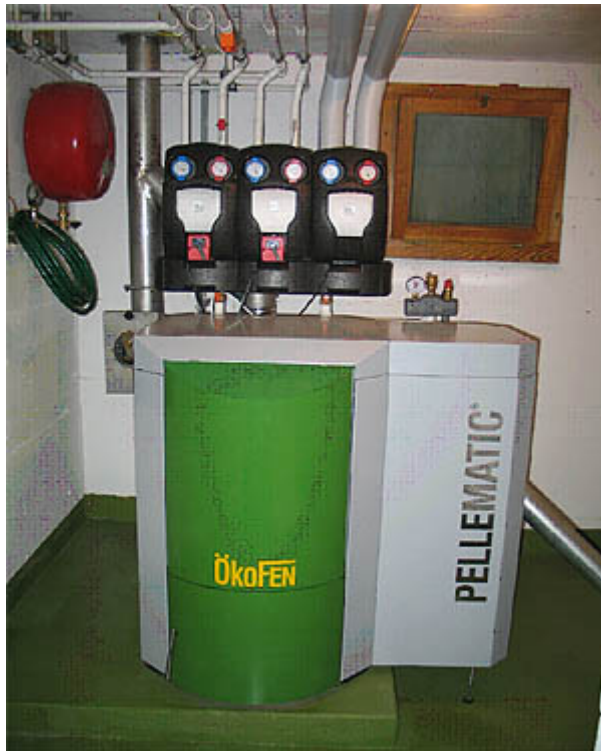
Pelletsanlage mit drei Gruppen für Fussbodenheizung, Radiatoren, Wasserpumpe
