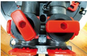
Das Wasser füllt jetzt die Anlage. Am Abfluss kommt Luft heraus. Dies dauert einige Minuten. Es fließt Luft und Wasser aus dem Abfluss. Lassen Sie das Wasser einige Minuten laufen, bis es klar und ohne Luft ist.
