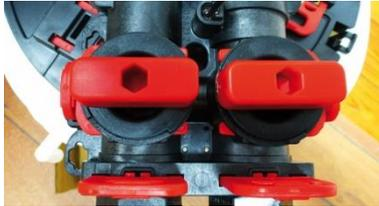
Nach Montage und Dateneingabe stellen Sie den Bypass in die „Bypass-Stellung“. Öffnen Sie jetzt das Absperrventil vor der Anlage und prüfen Sie, ob die Anschlüsse dicht sind. Öffnen Sie ein Ventil nach der Anlage und spülen eventuelle Verunreinigungen aus. Warten Sie ein paar Minuten bis das Wasser klar ist.
