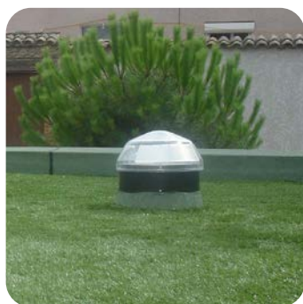
Toiture terrasse végétalisée
