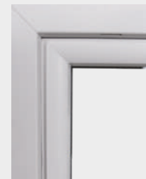
Désaffleur de l'ouvrant
