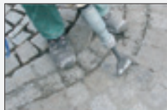
Aufstechen gebundener Fugen
