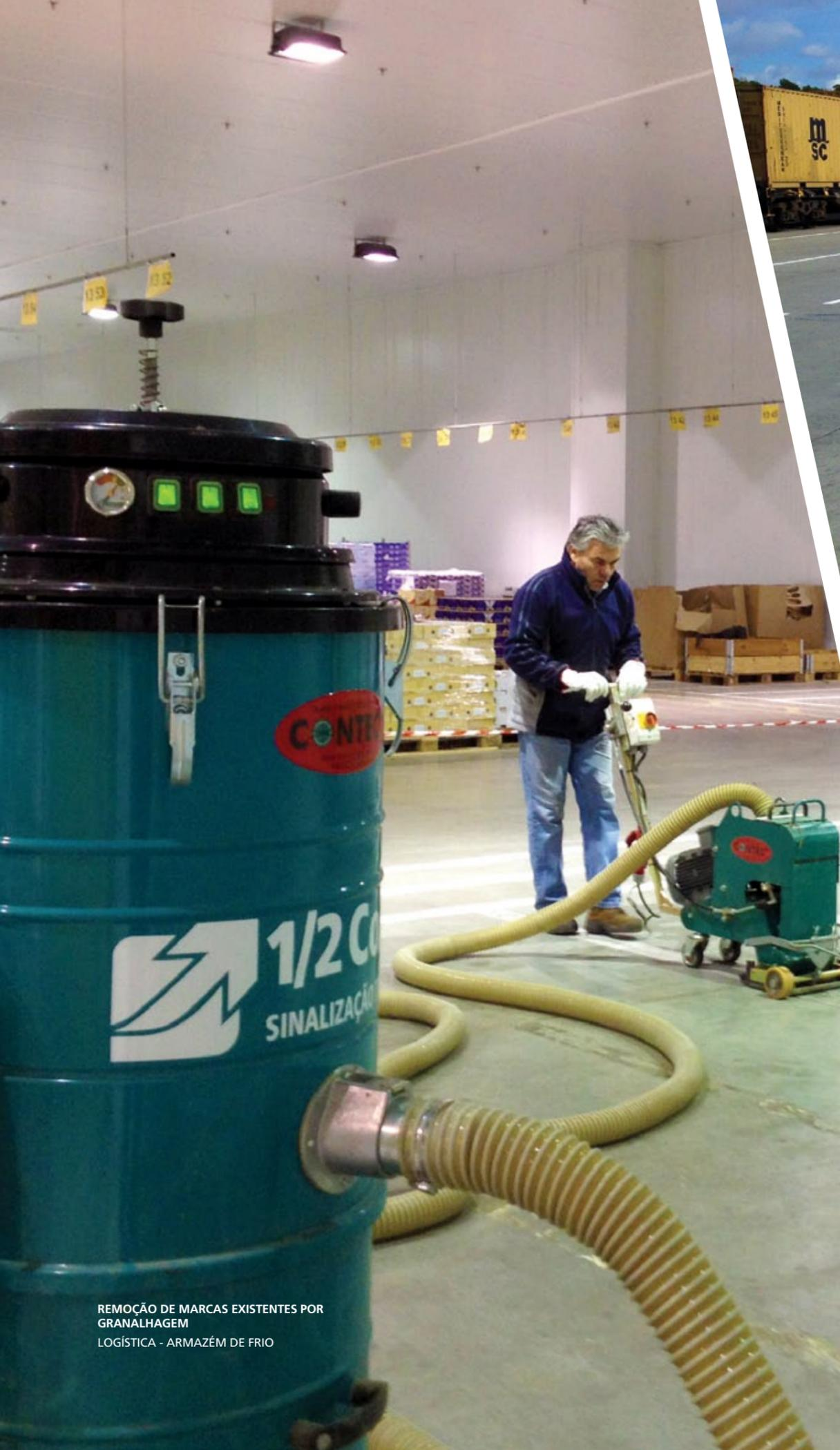
REMOÇÃO DE MARCAS EXISTENTES POR GRANALHAGEM
