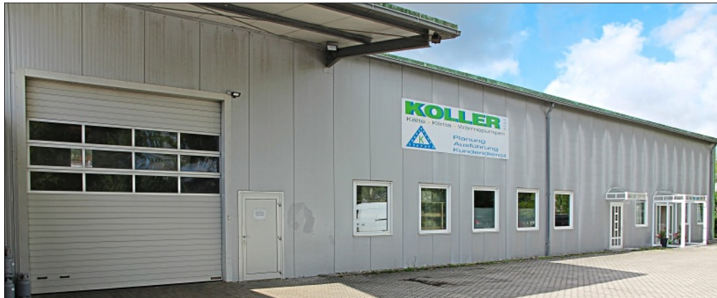
Der Neubau des Firmengebäudes in der Gewerbestraße in Vohburg war ein Meilenstein in der Firmengeschichte. Fotos: Zöllner
