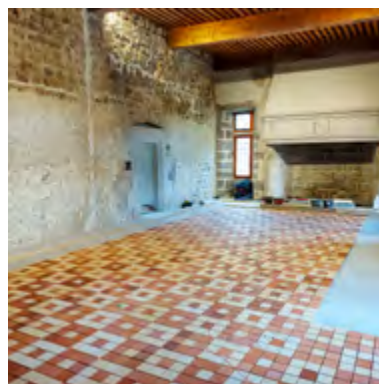
Enduits muraux, plancher et sol en tomettes respectant le style médiéval.
