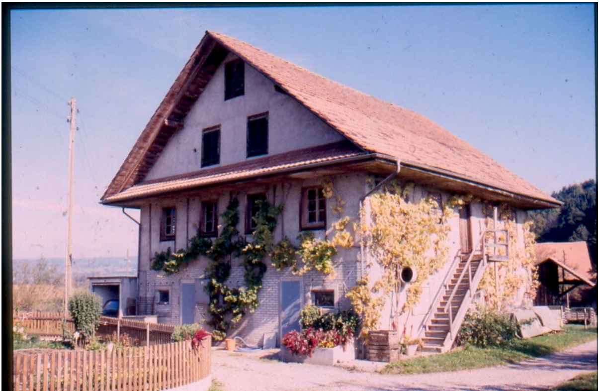
Abbildung 16: Käsereigebäude auf Dachsellern, gebaut 1857 von Josef und Jakob Ineichen (Bild Stadtarchiv Sempach).
