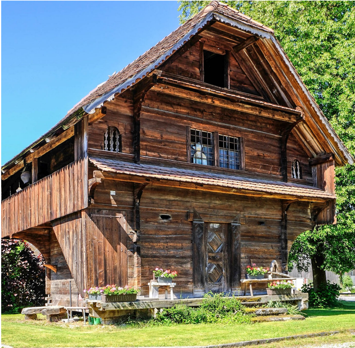
Abbildung 10: Dieser Speicher wurde 1762 auf der Dachsellere gebaut. Da er für die landwirtschaftlichen Tätigkeiten nicht mehr verwendet wurde, verkaufte ihn Josef Ineichen-Rüttimann Ende der Sechziger Jahre dem Kurt Stirnemann an der Hubelstrasse in Sempach. Der jetzige Standort wird in den nächsten Jahren überbaut, so dass er wieder auf den Hof Dachsellere zurückkehren darf (Foto Otto Schmid, 2026).
