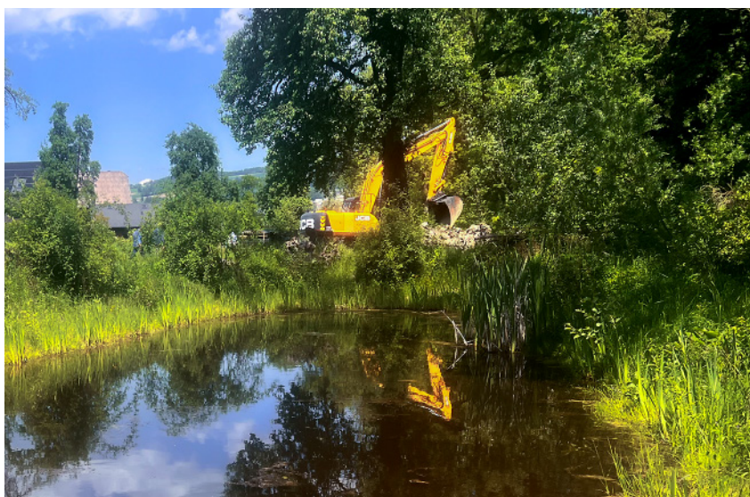
Abbildung 43: Umsetzung von Sofortmassnahmen an der Sure, Mai 2025. Foto: Andreas Meier
