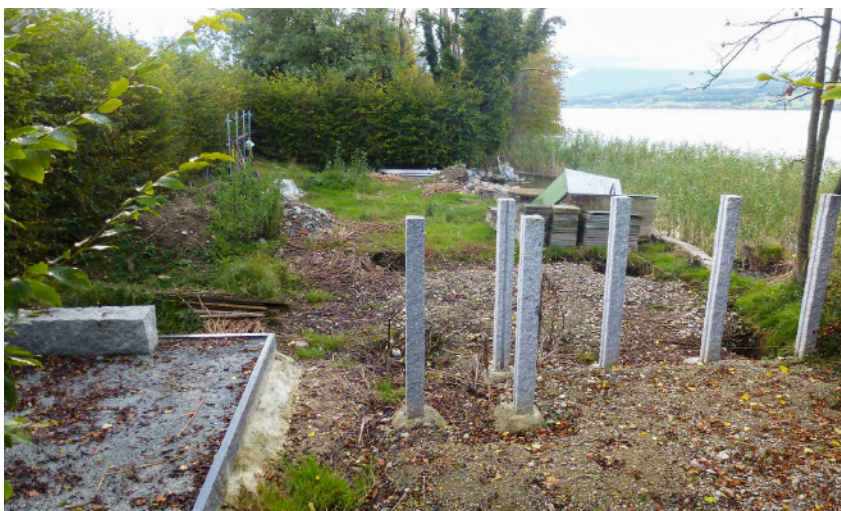
Abbildung 37: Intervention wegen Bauarbeiten am Seeufer. Foto: Josef Blum
