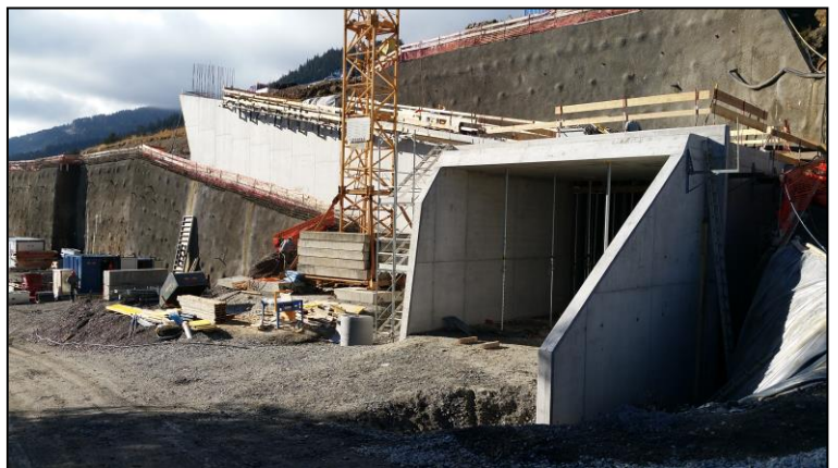
Tranchée couverte – ALRV - Aminona
