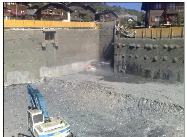
Abaissement culée Est pont Haut de Crans
