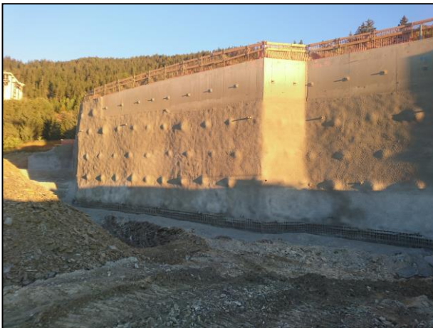
Enceinte de fouille - Iris et Lotus- Crans-Montana
