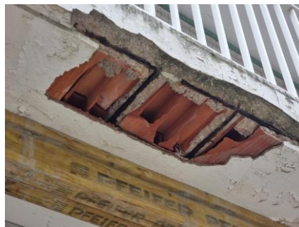
Sous-face de dalle : corps creux à nu
