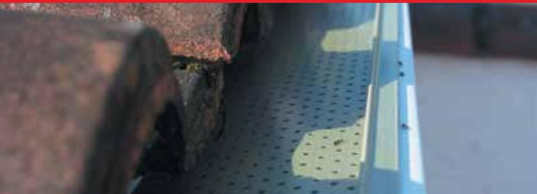
Le PARE-FEUILLES DAL'ALU est une protection de gouttière en aluminium empêchant l'accumulation des feuilles et des débris, et facilitant donc l'écoulement de l'eau, même en cas de fortes pluies.
