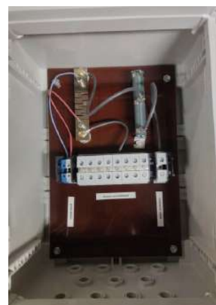
Mesure ajustable via résistance dans coffret 500x400
