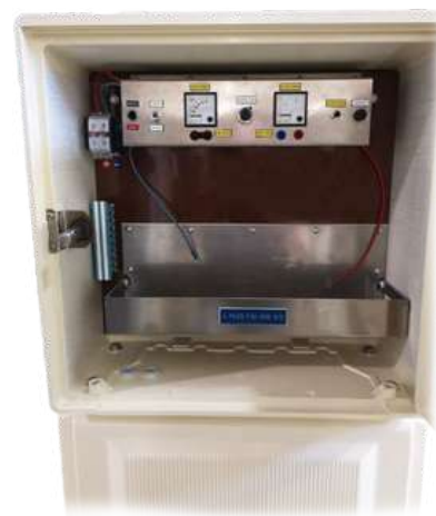
Piles dans S15/S300
