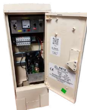
Piles dans S22
