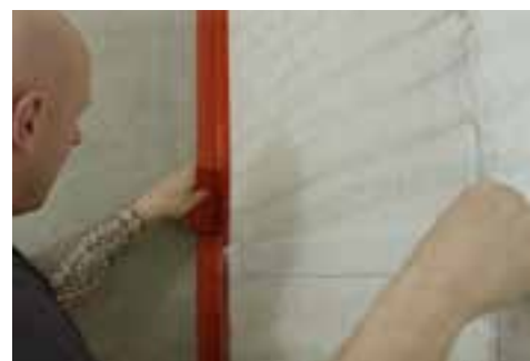
3. Eckdichtbänder anbringen
