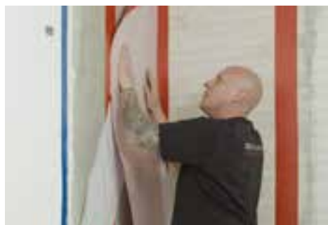
4. Dichtbahnen anbringen
