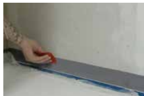
1. Wannendichtband verkleben
