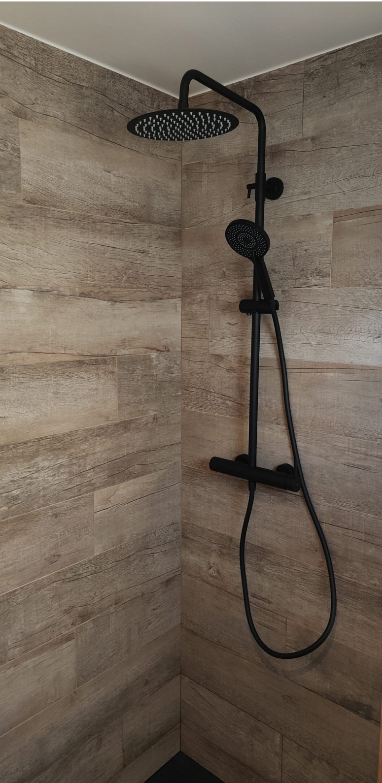
Baño en colaboración con electricista y fontanero.
