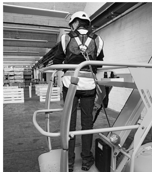
5 Attention en utilisant des systèmes de retenue: se servir uniquement des points d'ancrage autorisés et réduire au maximum la longueur de la corde de retenue (respecter la notice d'instructions).
