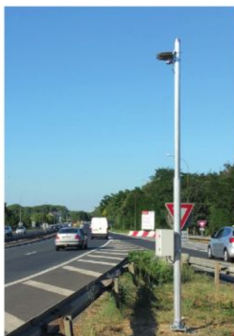
Capteur de détection de gabarit D523 Angers (49).
