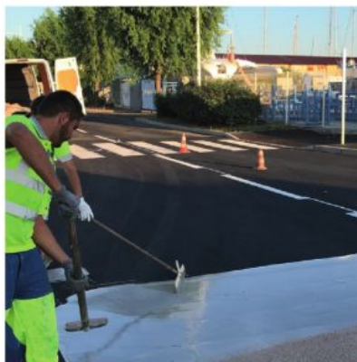
Résine ISOMARK® DIAMANT avec granulat de Granit - Port de Sète (34).
