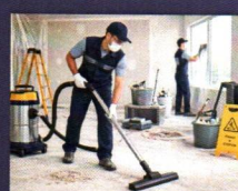
FIN DE CHANTIER
