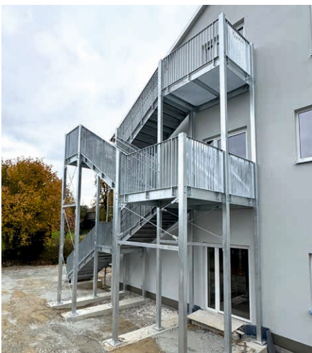
Beim Bau des Fluchtturms und des Spielbalkons der neuen Kita in Mitterfels erfolgte die Vermessung bereits per Laserscanner. Die anschließende Planung wurde präzise in einem 3D-CAD-Modell umgesetzt.
