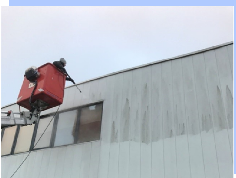
Nettoyage façade à haute pression à l'aide d'une : Nacelle élévatrice
