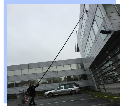
Nettoyage à la perche télescopique à l'eau pure (HI-FLO)
