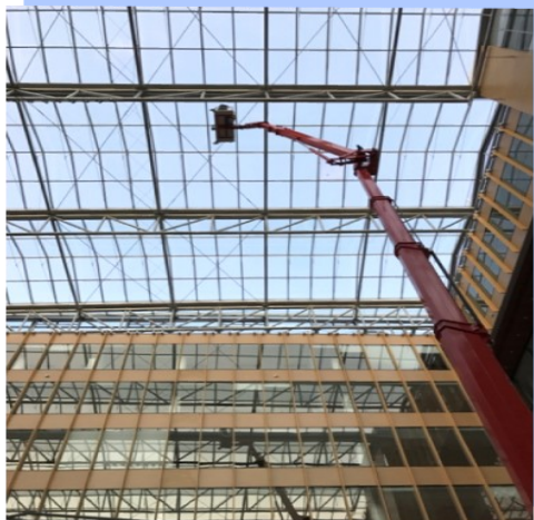
Nettoyage vitrerie intérieure à l'aide d'une : Nacelle araignée
