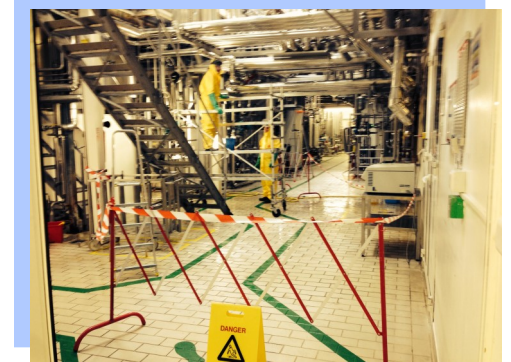
Nettoyage à l'aide d'un échafaudage d'une salle blanche avec produits chimiques
