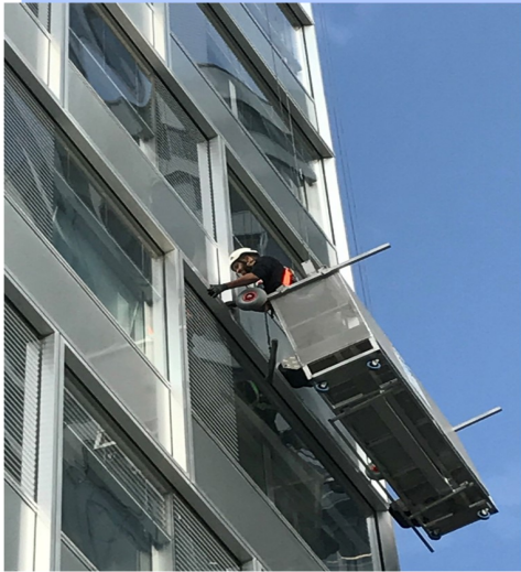
Nettoyage de façade à l'aide d'une : Nacelle de toit
