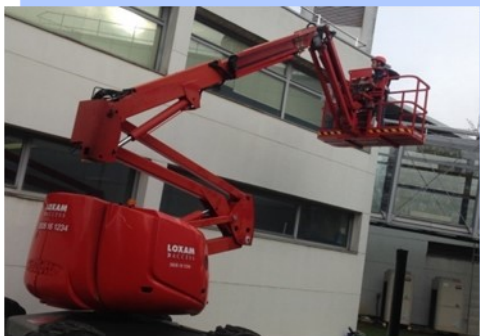
Nettoyage vitrerie à l'aide d'une : Nacelle automotrice
