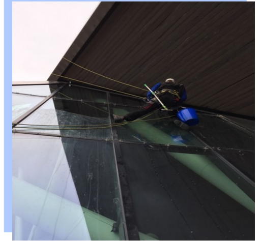
Nettoyage vitrerie : Travaux sur cordes — alpiniste
