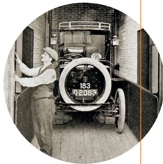
Après seulement 4 ans, nous avons installé plus de 600 ascenseurs.
