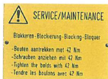
Fig. 6 Schild mit Schrauben-Anziehmoment für Seiltrommelblockiereinheit
