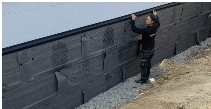
Thermodren fest á múrsteinsvegg, með millirönd á efri hlutanum.
