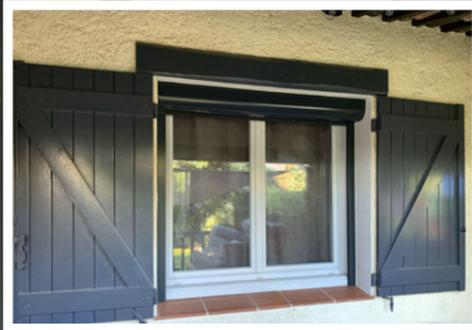
Volet roulant traditionnel pose dans coffre-tunnel
