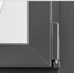
Couvre-joint intérieur aligné avec le dormant
