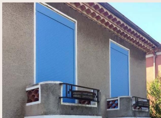
Pose tableau enroulement intérieur
