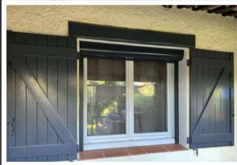
Volet roulant traditionnel pose dans coffre-tunnel
