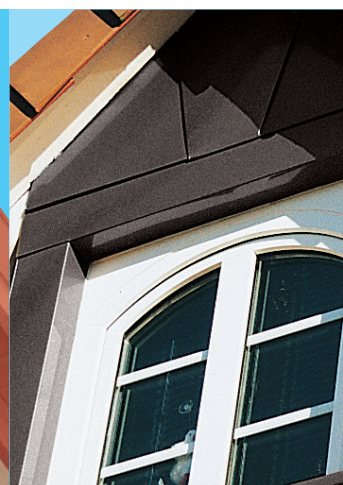
Habillage de façade / chien assis
