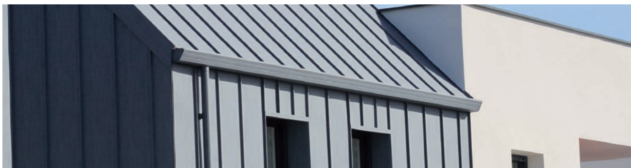
Joint-debout DAL'ALU - Certifié CSTB - Réalisation BOUYGUES CONSTRUCTION / BALLESTRERO / Chantier de Montévrain (77)
