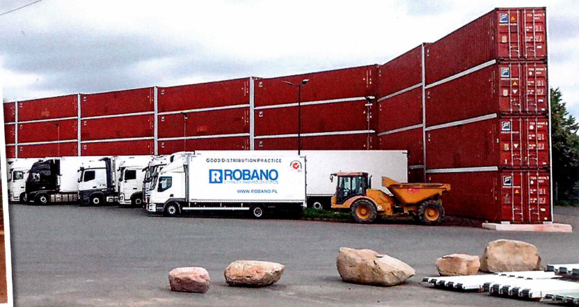
Eine Lärmschutzwand aus Containern von Supreme Trading erlaubt es dem Logistikzentrum, dem die Schließung angedroht wurde, weiter zu arbeiten.
