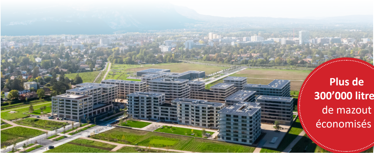
Quartier Belle Terre, Thônex (Source : Belle Terre).
