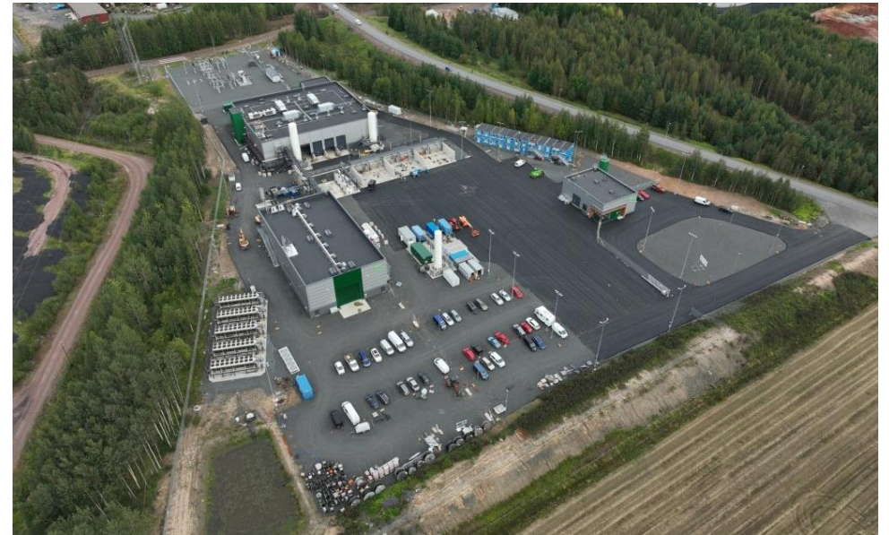
P2X Solutions Oy:n teollisen mittakaavan uusiutuvan vedyn ja synteettisen metaanin tuotantolaitos Harjavallassa (20 MW).
