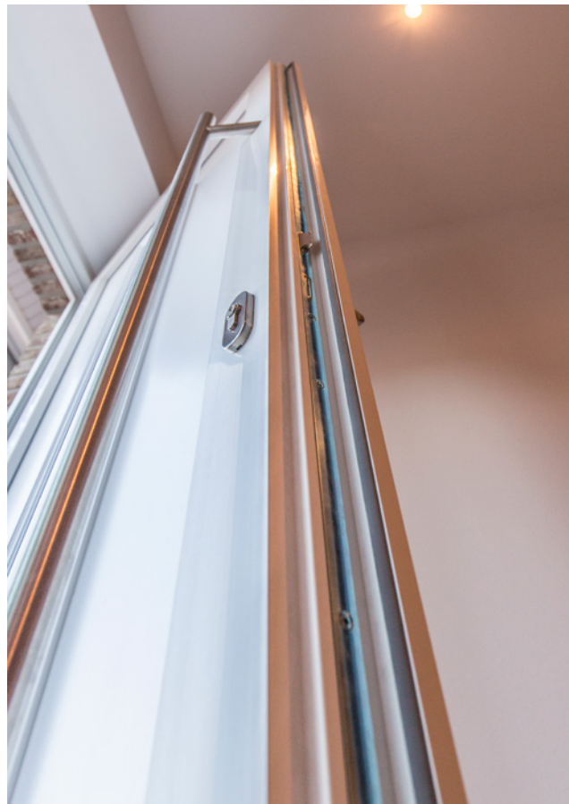
Uit een deel vervaardigde sluitplaat voor meer veiligheid
