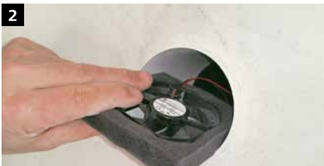
Lüftungsanlage von der Stromversorgung abschalten. StoAirtherm Einschublüfter vorsichtig herausziehen.
