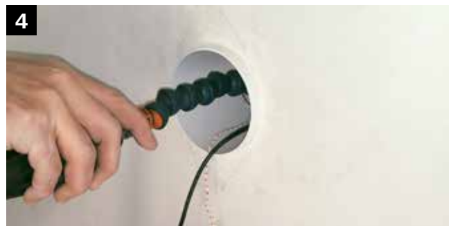
Staubsaugerschlauch einschieben, bis er am Wärmetauscher anstößt, und Staubpartikel absaugen.
