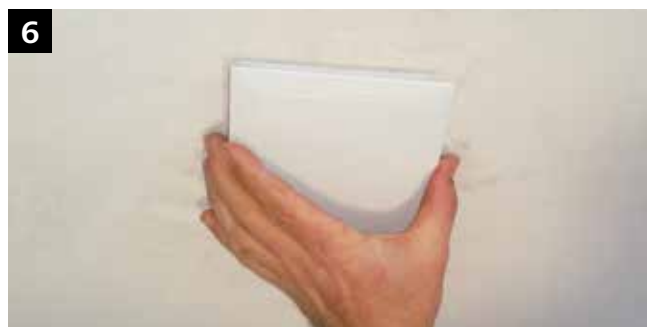
StoAirtherm Innenraumblende wieder einsetzen.
