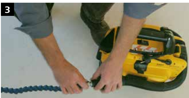
Geeignete Staubabsaugung wie z. B. von Kärcher der Akku-, Nass- und Trockensauger, Typ DeWalt DCV584L, wird mit einem speziellen, flexiblen Saugrohr bestückt.
