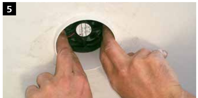
StoAirtherm Einschublüfter wieder einsetzen. Es muss dabei darauf geachtet werden, dass die Etikettierung zu sehen ist (Lüftungsrichtung).
