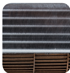
Sisäyksikön lämmönsiirrin 10 vuoden jälkeen ilman pinnoitusta.
