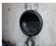
Carottage et joint
