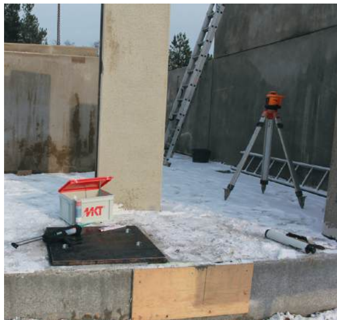
Kartusche VMU plus 825 Side-by-side Kartusche Inhalt: 825ml Mit großem Mischer VM-XL und Reduzier-/ Verlängerungsrohr für Bohrlöcher ab 12mm Durchmesser
