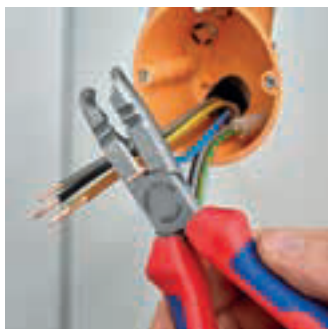
Schneiden beim Einkürzen von Einzelleitern
