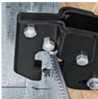
Das Stempelwerkzeug wird durch die Profilbleche gedrückt
