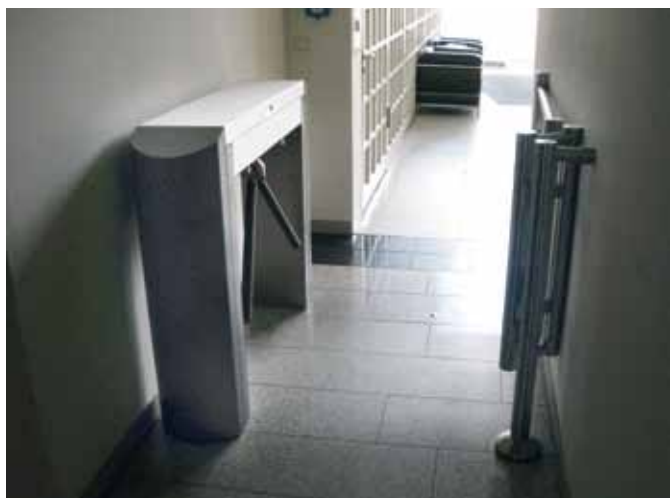
2-Arm-Drehsperre „Regensburg Klassik“ mit Falttür, barrierefrei geöffnet
