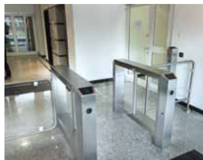
Schleuse „Starnberg“ in Edelstahlausführung mit verdecktem Lesereinsatz unter Acryl
