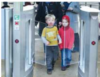
Schleuse „Schwabing“ mit erhöhtem Sockel zur Erkennung von Kleinkindern
