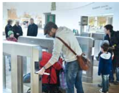
Schleuse „Schwabing“ mit Extension-Modul zur Erkennung von z.B. Kinderwagen
