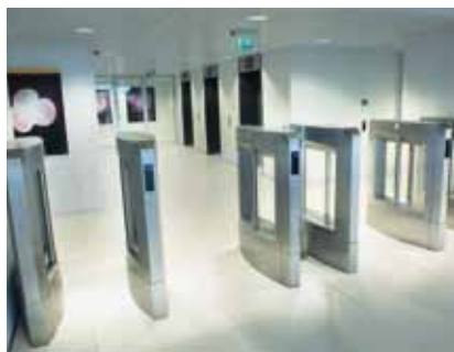
Schleuse „Schwabing“ mit erhöhtem Sockel für zusätzliche Sensorik
