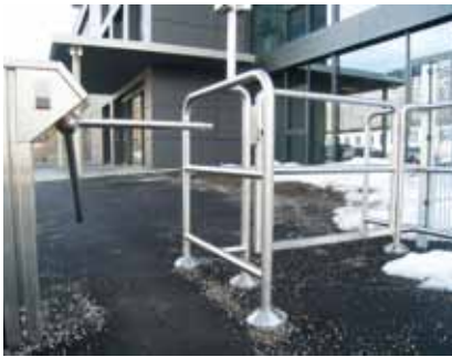
Firmenzugang mit Drehsperre „Oberstdorf“ und mechanischer Personentür
