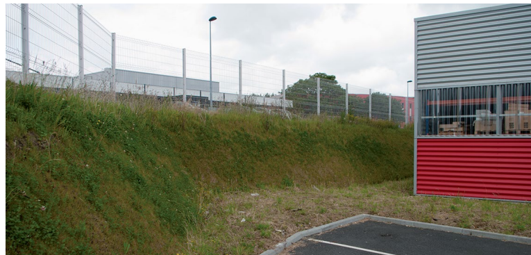
Végétalisation d'une paroi de déblais autour d'une plateforme commerciale
