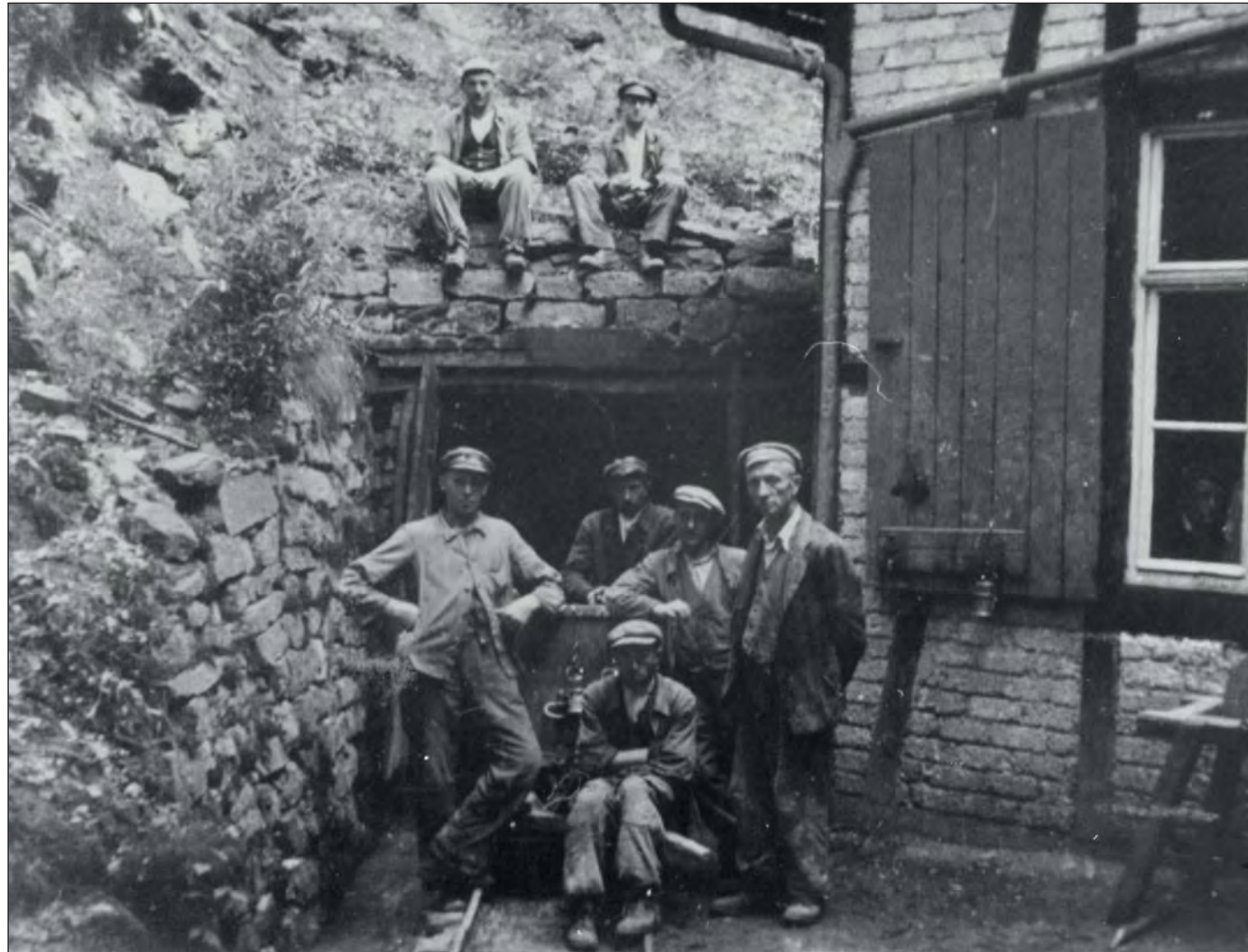
Schwerspatgrube in Partenstein
