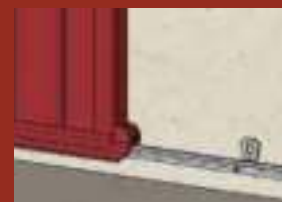
Réglette support en partie basse pour porte-fenêtre
