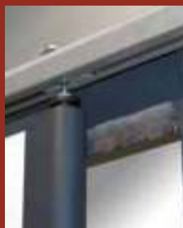
Précadre aluminium laqué + joint brosse et joint caoutchouc d'étanchéité
