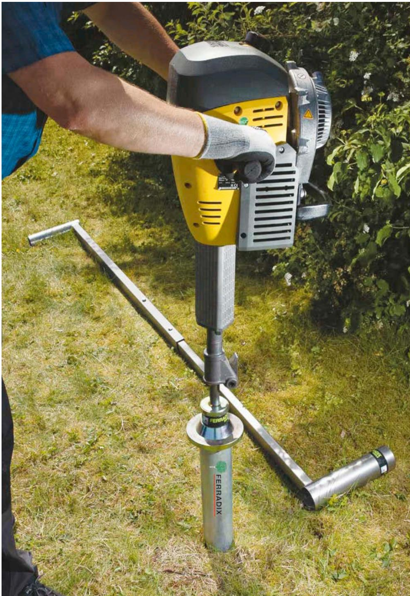
Luonnolliseen maaperään: FERRADIX® Country aita-ankkuri. Tolppien tarkat paikat saa merkittyä mittatyökalumme avulla (FERRADIX® -työkalut)
