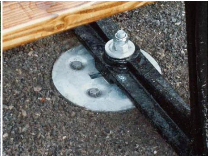
Kiinnityskansi säädettävällä kiinnityspisteellä: mahdollistaa erilaisten penkkien ja mm. koulunpihamaalien kiinnittämiseen ehkäisten niiden siirtämisen ja kaatumisen.
