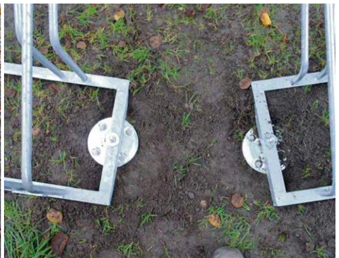
Kiinnityskansi säädettävällä kiinnityspisteellä: mahdollistaa erilaisten penkkien ja mm. koulunpihamaalien kiinnittämiseen ehkäisten niiden siirtämisen ja kaatumisen.
