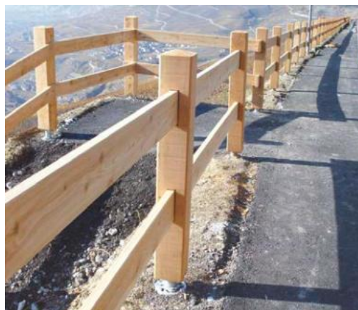
Wallisin kantoni: puukaiteet asennettu FERRADIX® Alpha -ankku-reilla (lisävarusteena "GOTHIC" -puutolppakiinnikkeet)
