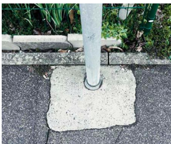
Entinen tapa: asentaminen betonilla
