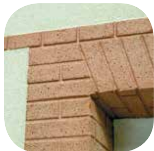
Linteau pose allongée rayonnante sans joint
