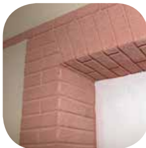
Linteau pose allongée rayonnante avec joint croisé
