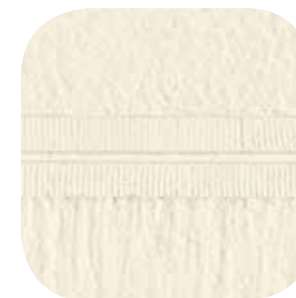
Joint pierre ciselage en pourtour du joint
